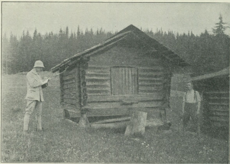
Fig. 17. Stolpbod. Tennbodarna, Älfdalen, Dalarna.
