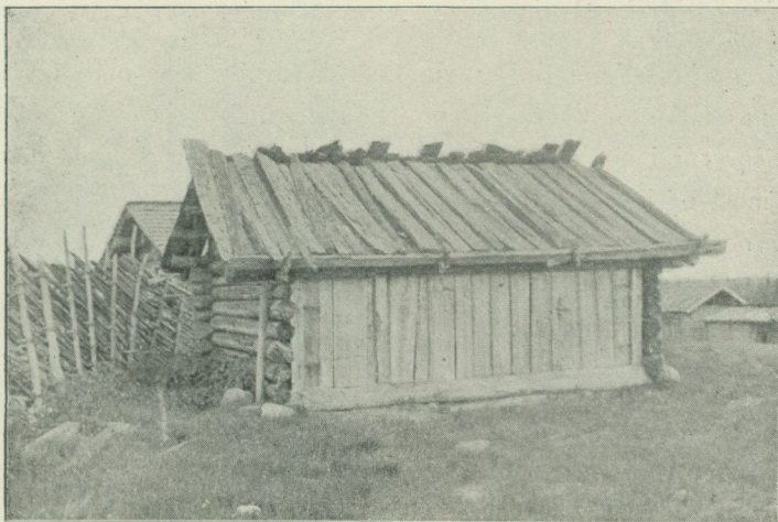
Fig. 1. Stall med stafkonstruktion. Hedbodarnas fäbod, Älfdalen, Dalarna.
