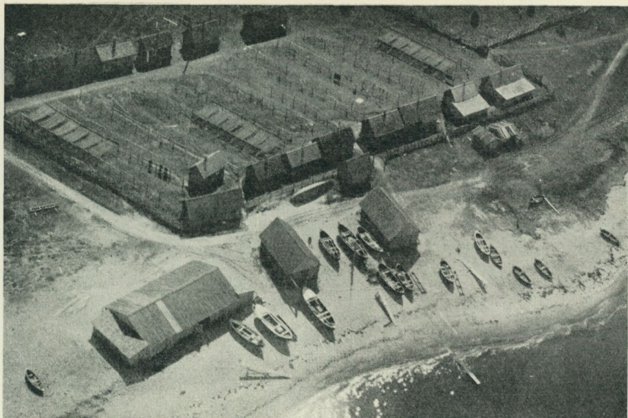
Bild 3. Djauveik. Bodarna ordnade i två parallella rader med "gisträum" ovanför var rad och allt inom en gemensam hägnad. — På stranden ett par bryggbockar och ett par uppdragningsbanor. Foto marinen 1932.
