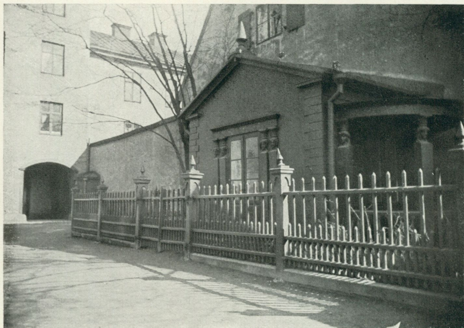
Bild 11. Lusthuset såsom gårdshus utmed södra tomtgränsen Bellmansgatan 24. Staketet med sin grind troligen från 1800-talets mitt. Foto skänkt till Nordiska museet i juni 1892.
