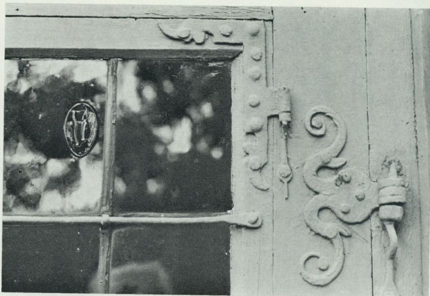
19. Gångjärn, vin- kelbeslag och stormjärn på dörren till lusthuset i Skogaholms träd- gård från omkr. 1700.
