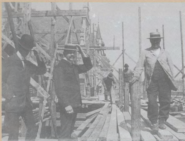
Ovan. Denna bild av männen på spängerna och murarna i arbete med vindsrummens gavlar på södra delen av byggnaden togs i augusti 1903.
