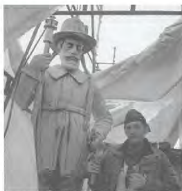
Figuren på norra gavelns krön under reparation 1996. Det är en krigare i "1600-talskostym" enligt skulptören Gustaf Malmquists räkning för arbetet med gipsmodellen som han levererade i oktober 1895. Den drevs i koppar året därpå av L. Millstrand. Malmquist gjorde senare Karl X Gustavs ryttarstaty som står framför museet
