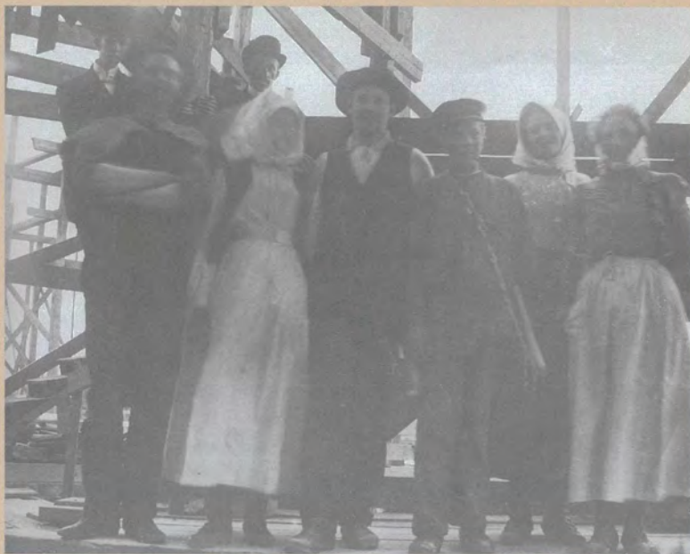
Till höger. Brukbärlaget vid bygget i oktober 1903. Den 24 november 1894 hölls taklagsöl. Förteckning på alla deltagarna finns i räkenskaperna, bara män, inga kvinnor.
