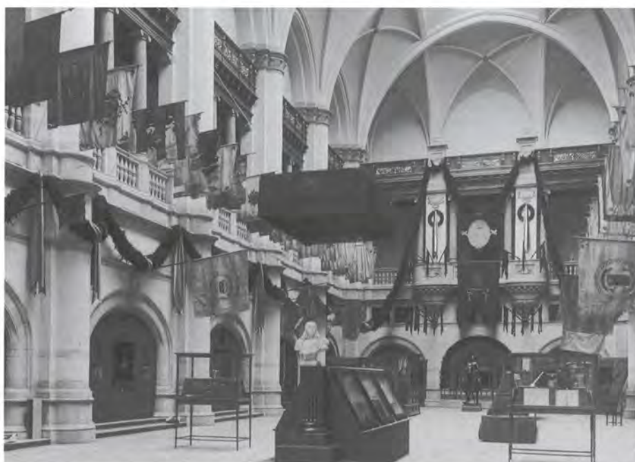
Tankarna på Allmogehallen som den stora mötesplatsen vid fosterländska fester ommöblerades genom att valven byggdes igen och ljusflödet från gallerierna stängdes ute genom att slutna utställningsrum skapades. Hallen blev ett stort slutet rum som fick härbergära Livrustkammaren. Från Karl X Gustav-utställningen 1908. Foto Anton Blomberg.
