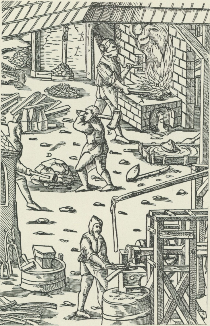
Bild 3. Vattendriven stångjärnshammare på 1500-talet. Ur Agricola, De re metallica , 1556.
