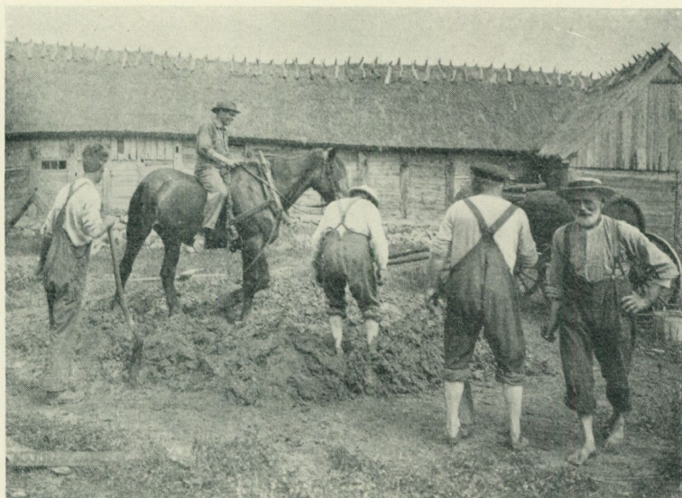
Fig. 8. Leran till klineväggarna ältas. Från Fredriksdahls friluftsmuseum vid Hälsingborg. Foto Torsten Mårtensson.
