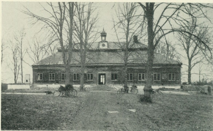
Fig. 4. Under nedmärkningen kunde man konstatera, att Skogaholmsbyggnaden ursprungligen sett ut på ungefär detta sätt: rödfärgad och utan hörnpaviljonger. Alla prydnads element på fasaden äro dock här borta, såsom fönsterfoder, fönsterluckor och knutpilastrar. Jämför den tecknade rekonstruktionen, sid. 163 i Lindbloms uppsats.
