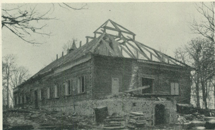
Fig. 5. En bild från nedmärkningen, som visar att flygelpaviljongerna ej varit med från början. Hela gaveln är rödfärgad och man ser till vänster ett ursprungligt fönster, som förändrats till dörr och sedan igensatts. Gavelfönstret till höger har varit överputsat och den ursprungliga karmen sitter därför kvar.
