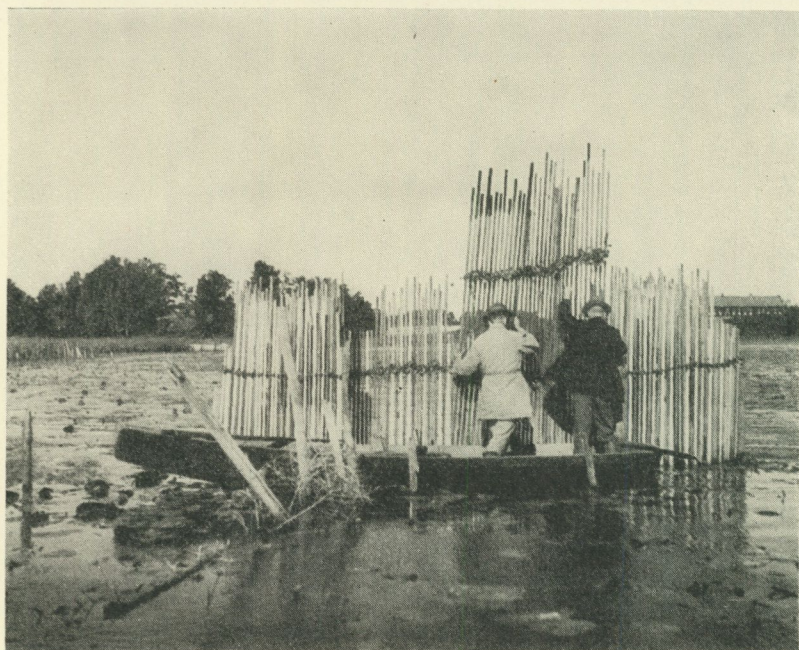
Bild 14—15. Upptill: Första golvet sättes i sjön. Nedtill: Skrovgår'ns inre vägghalva sättes ut.
