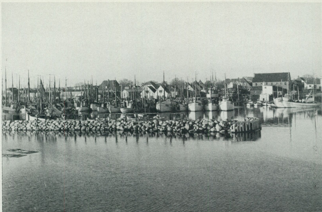
4. Ved Strandby blev der 1893 bygget en lille havn, der siden er blevet udvidet i takt med det voksende fiskeri. Stranden med store flader af lavt vand var et yndet legested for børn, der boede i nærheden af kysten. David Yde-Andersen fot. 1957.
