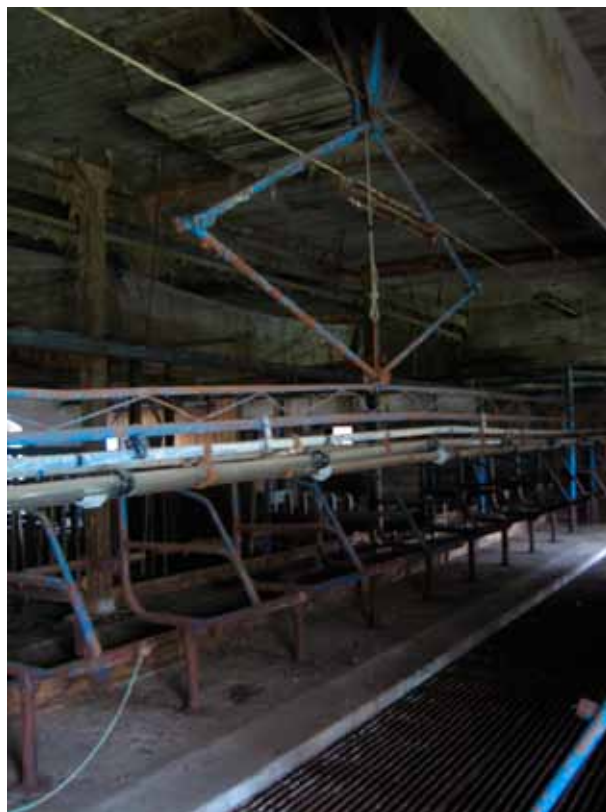
Den nedsänkbara mjölkledningen på Ryholm. Foto: Ulrich Lange.
