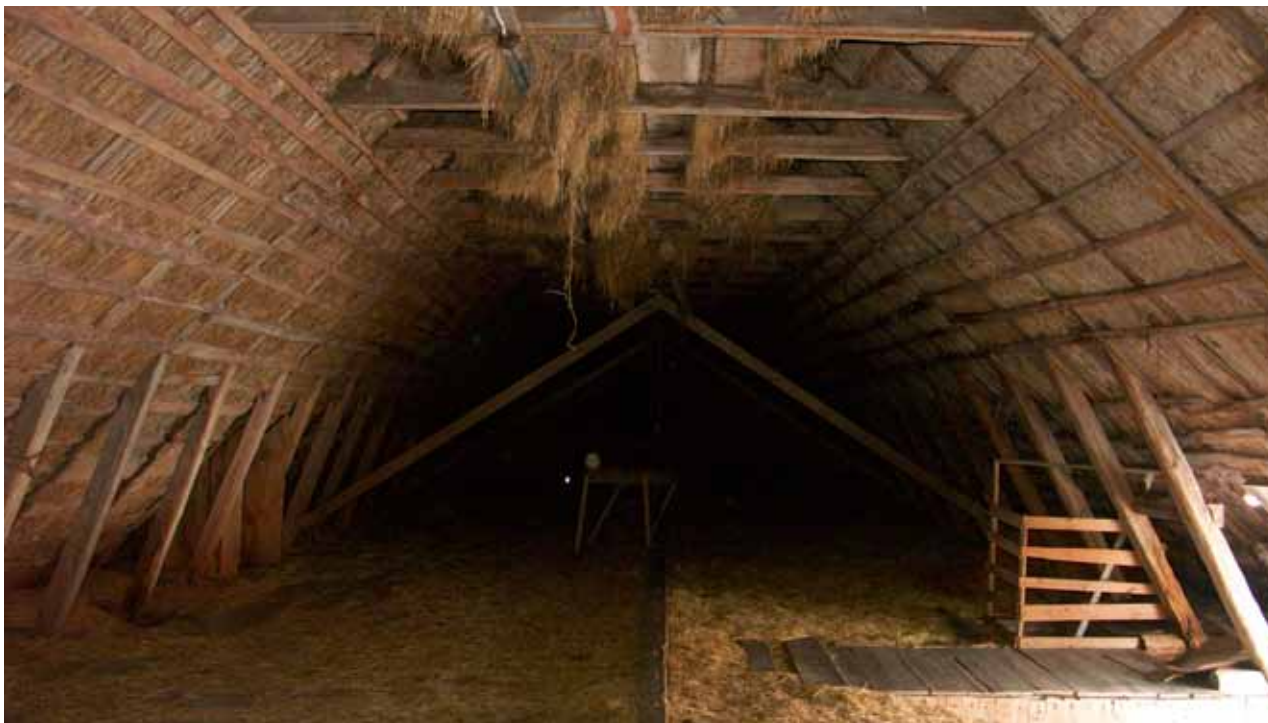
Lagmansö. På hövinden ovanpå stallet finns takstolen från 1760-talet med sitt halmtak ännu bevarad. Foto: Kjell Taawo.
