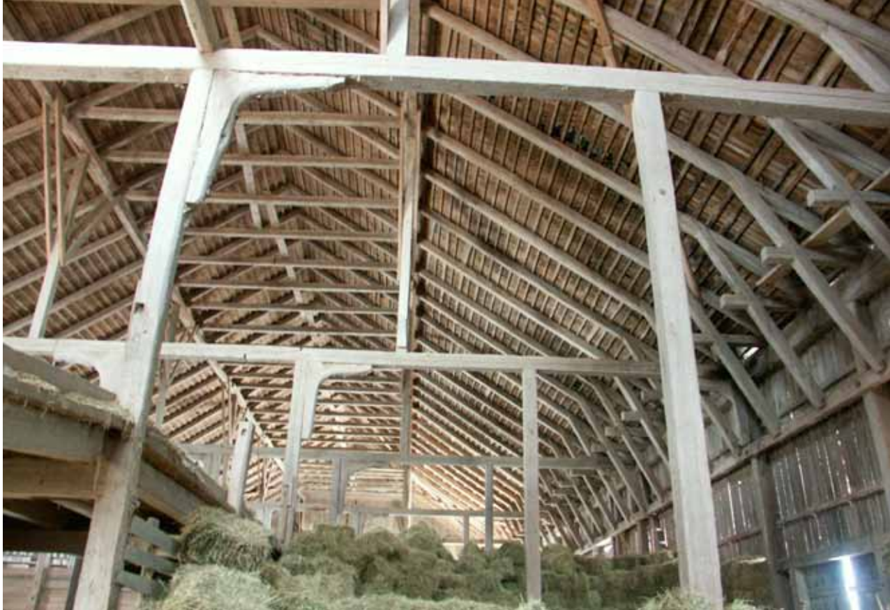
Logen på Lagmansö uppfördes under 1880-talet i stolpverksteknik. Det medgav skapande av en kolossal rymd. Foto: Kjell Taawo.
