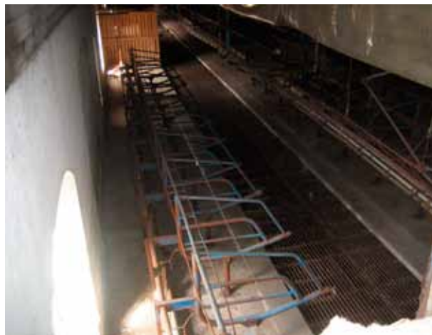
Interiör från ladugården i Ryholm 2010. Plaströret i taket ingår i ventilationssystemet. Gödselgallret täcker det flera meter djupa schaktet. Foto: Ulrich Lange.
