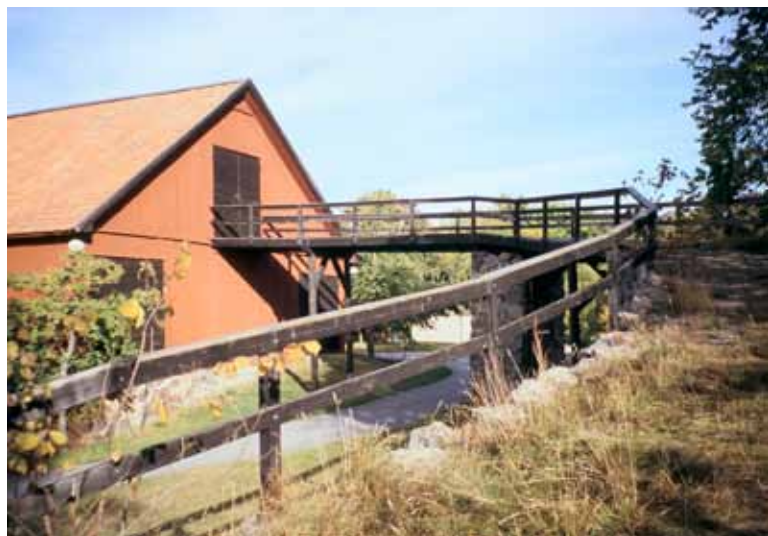
Skullbro till logen på Ultuna dåvarande lantbruksinstitut utanför Uppsala. Foto: Ulrich Lange.
