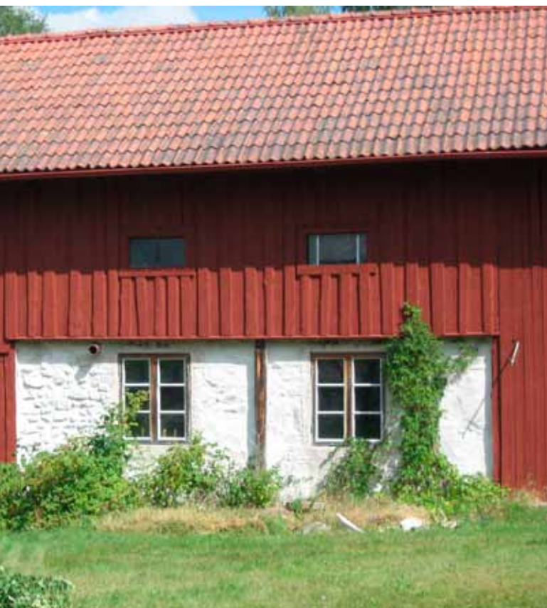
Putsad ladugård i gjuthusteknik, Almo, Siljansnäs i Dalarna. Foto: Ulrich Lange.
