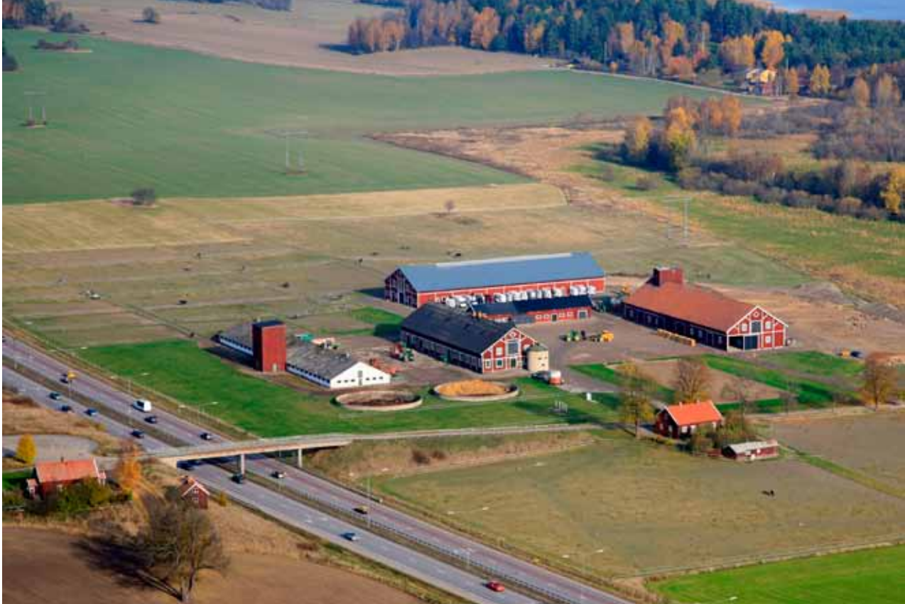
Vallstanäs gård i Norrsunda socken, Uppland. Bilden visar hundra års byggnadsutveckling i fågelperspektiv med tre generationers byggnader. De två parallella längorna, ladugården t.h. och logen t.v. med ett lider emellan, är från 1893 och tillkomna sannolikt efter ritningar av Wilhelm Steinholtz. 356 Påbyggnaden på logens tak tillhör en senare spannmålstork. Mot motorvägen till ligger det för 1950-talet karaktäristiska låghuset med sitt höga foderhus. Bakom ligger en ridhusanläggning från sekelskiftet 2000 som upptagit det förra sekelskiftets dekorativa snickarglädje. Foto: Wallstanäs AB.
