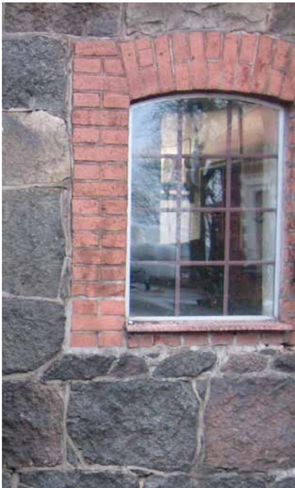
Tegelomfattningarna i den välhuggna gråstenen i Ulatoftas ladugård. Foto: Ulrich Lange.
