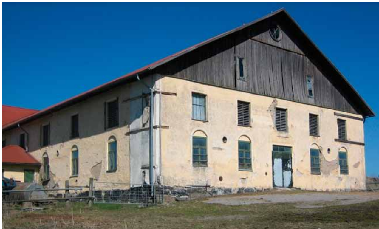
Ladugårdskomplex i obränd lera på Rikstens gård söder om Stockholm. På de allra flesta lerhusen byggdes gavelröstena på detta sätt, i trä. Foto: Ulrich Lange.
