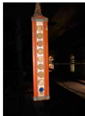
Manöverpanel för nedsänkning av mjölkledningar och gödselgaller. Ryholm. Foto: Ulrich Lange.
