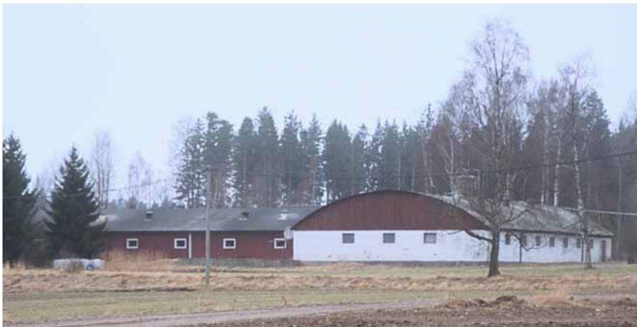
Två med Bläcken minst lika annorlunda lösdraftsladugårdar i Västergötland. Den trekantiga ligger i Karleby utanför Falköping och byggdes 1957 för 20 kor enligt ritningar av Lars Olof Stövling i Skara. 304 Den med välvt tak återfinns sydost om Mariestad. Foto: Ulrich Lange.
