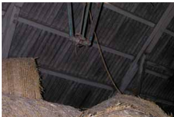
Även i gamla byggnader kunde höhiss installeras men då behövde hanbjälkarna sågas av, som här på Nolgården. Foto: Marie Odenbring Widmark.
