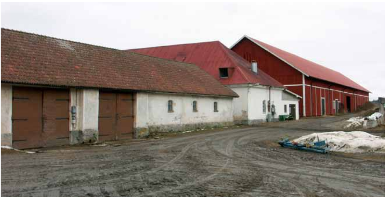
Svinhuset till vänster, ladugårdsgaveln i mitten och logen till höger. Foto: Kjell Taawo.
