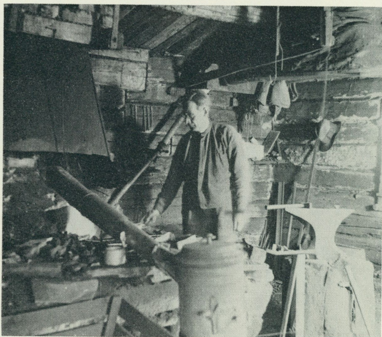
Saxsmeden Ernst Lindkvist vid ässjan i smedjan. Bälgen är upphängd i taket bakom smeden. Foto författaren 1942.
