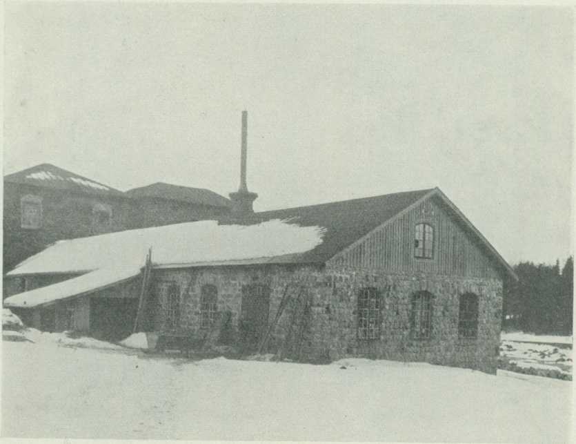
Fig. 8. Ljusne masugns utseende 1920. Foto N. Åkerhielm. Byggnaden med fönster är det omändrade malmhuset, längst t. v. rostugnen, vars skorsten är borta, strax t. h. därom skymtar själva masugnen.
