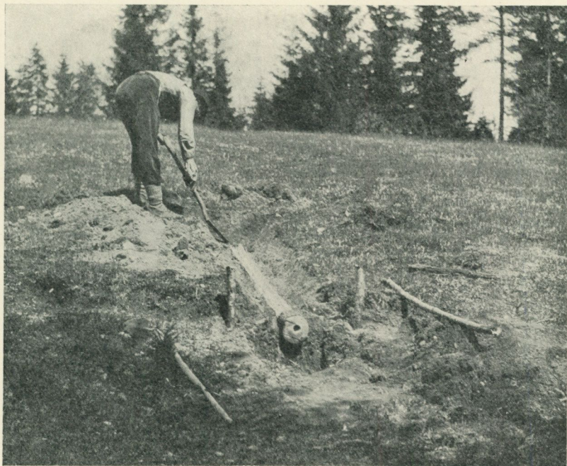
Fig. 1. Tjårdike med träränna.
