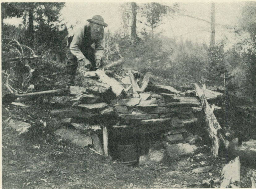
Fig. 17. Samma ugn som i fig. 15. Över den inresta veden är en gryta stälpt, och på denna brinner en stockvedsbrasa.
