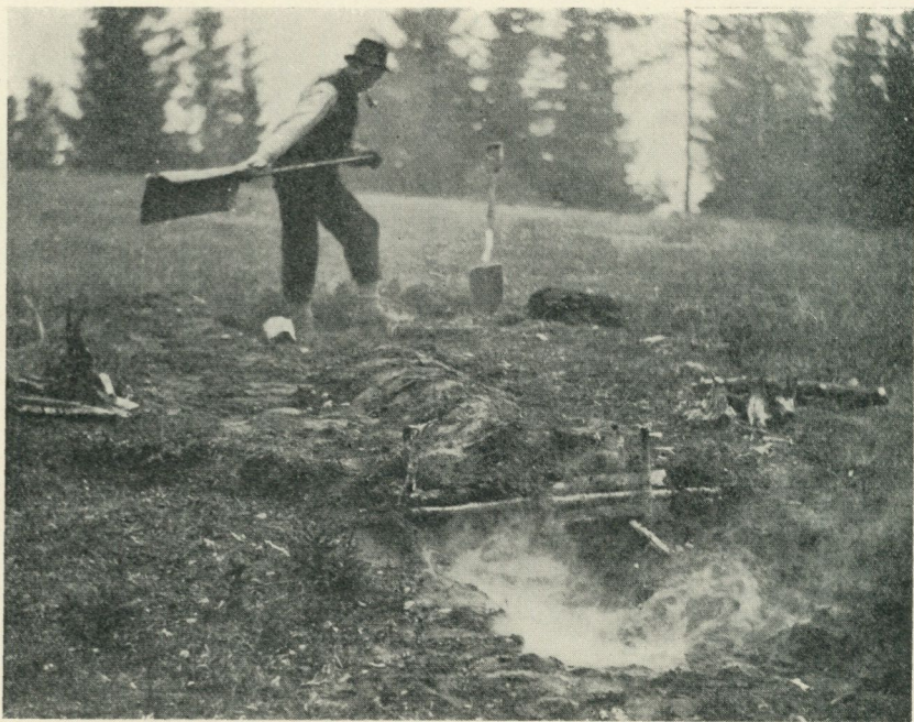
Fig. 4. Diket, »drevgraven», färdigt och täckt med jord. Veden har tändts; tjärbrännaren fläktar med en »näverbläs». I förgrunden ses rök framtränga.
