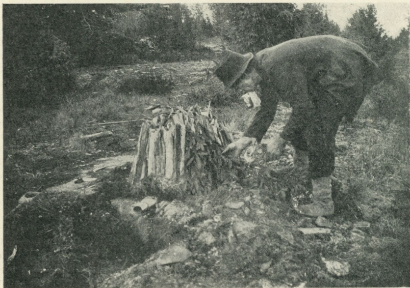
Fig. 10. Tjärmila täckes med granris. Över bergkanten framskjuter en näverpipa, vilken utgör avloppet för tjäran.
