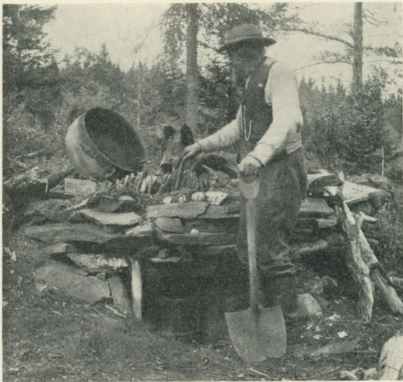
Fig. 16. Tjärugn, murad av gråsten. Töret inreses i »karet». Den gamle tjärbrännaren (numera 93 år gammal) heter Jan Jansson och är från Porna i Mangskog.
