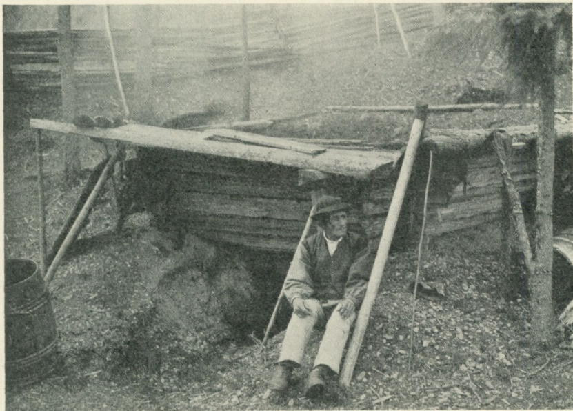
Fig. 9. Gamle »Pägers» (Pekkas) tjärgrav i Lekvattnet, belägen å branten nära Rottna älv. Töret i graven ännu rykande, men hopsjunket på grund därav att bränningen lider mot sitt slut.
