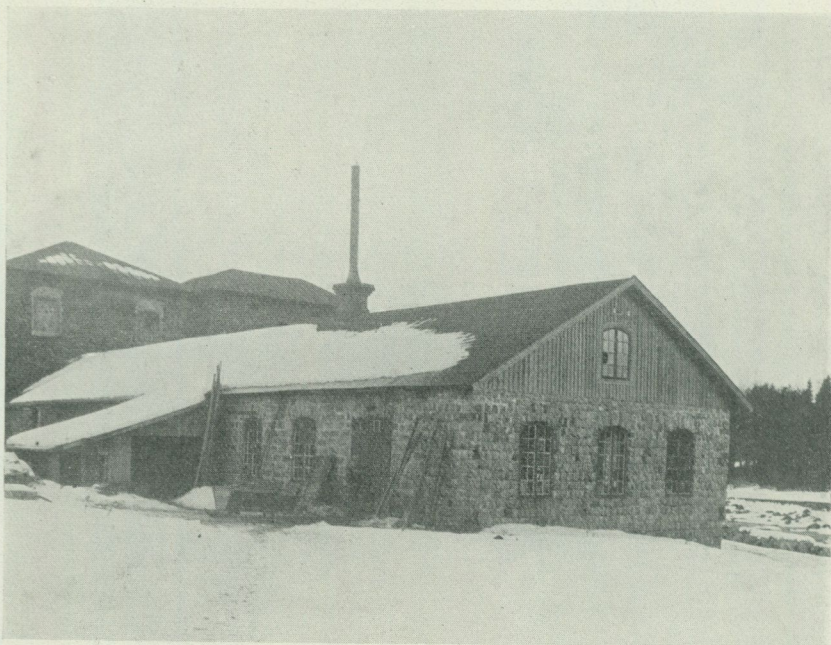
Fig. 8. Ljusne masugns utseende 1920. Foto N. Åkerhielm. Byggnaden med fönster är det omändrade malmhuset, längst t. v. rostugnen, vars skorsten är borta, strax t. h. därom skimtar själva masugnen.
