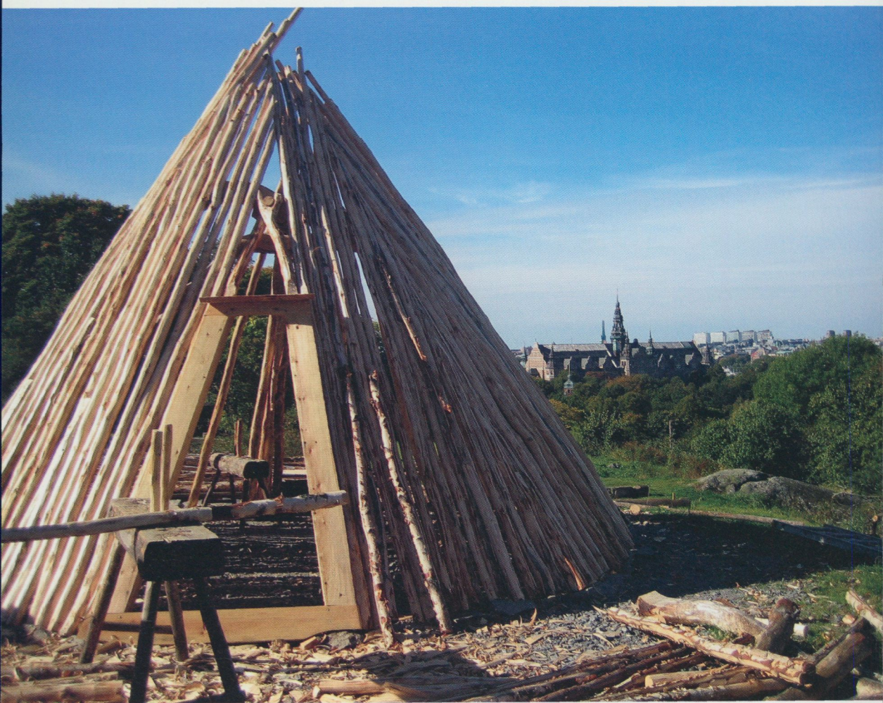
Skansens torvkåta under uppbyggnad 2005. Foto Eva Silvéen.
