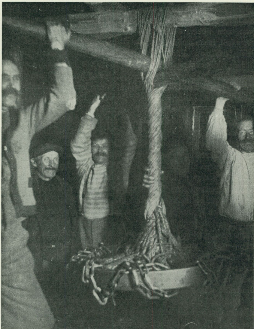
Fig. 2. Smörjning av läderrepet under bråkningen. Foto. A. Jernberg.
