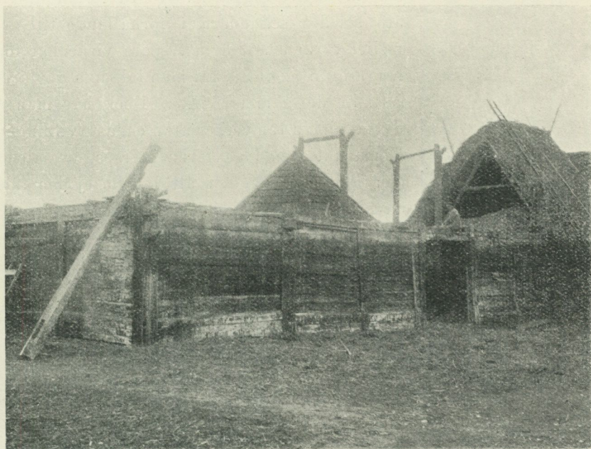
Fig. 3. Lada, Biskops, sedan taket nedtagits. Förf. fot. 1909.
