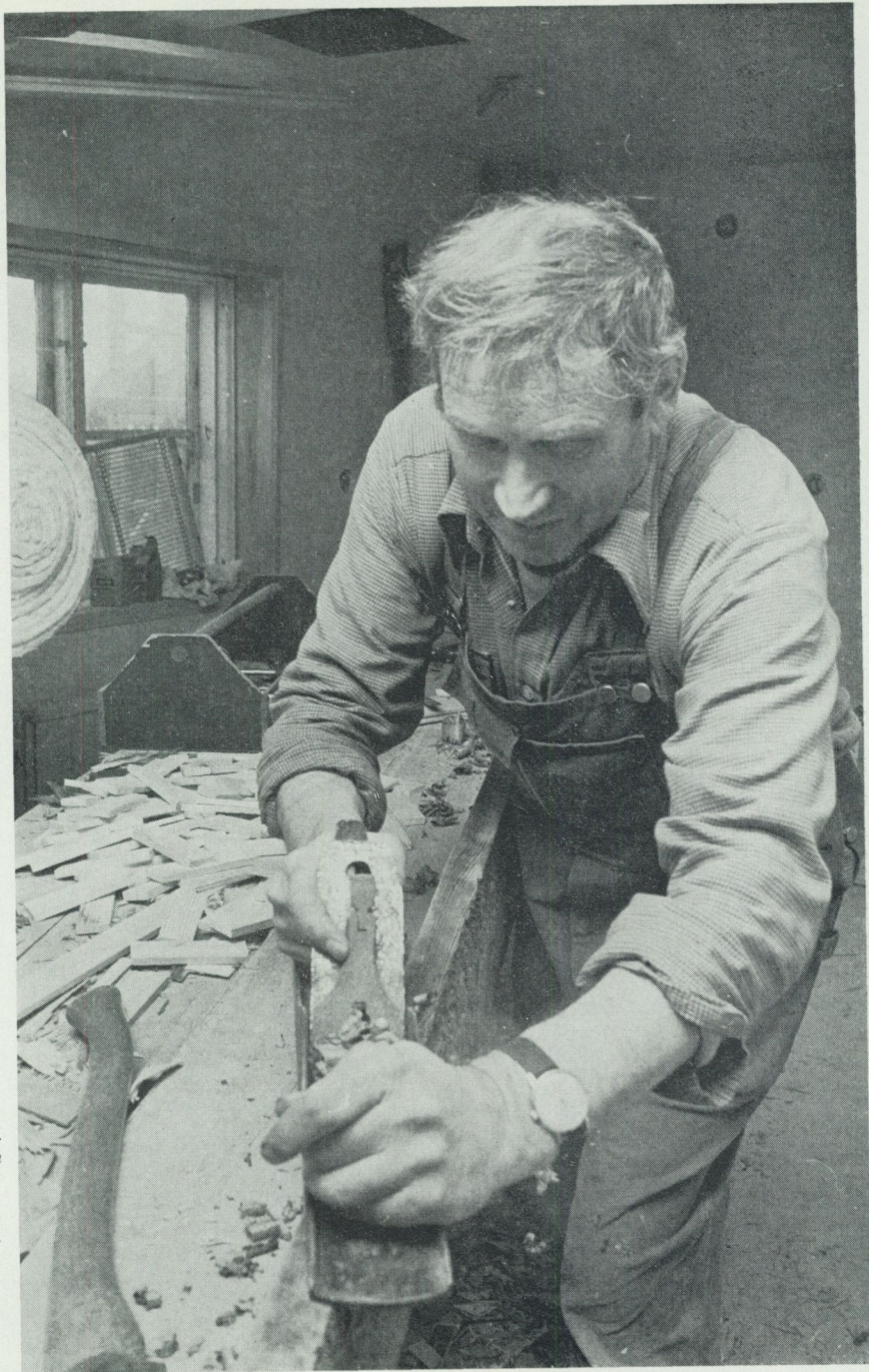
4. John Gjers, Skansen, riktar kanten på en golvbräda i Stora Gungan. Bräderna i det här golvet hade mycket varierande tjocklek. Därför måste varje bräda läggas in individuellt och kilar under. Kilar ligger på bänken till vänster. Foto 1974.
