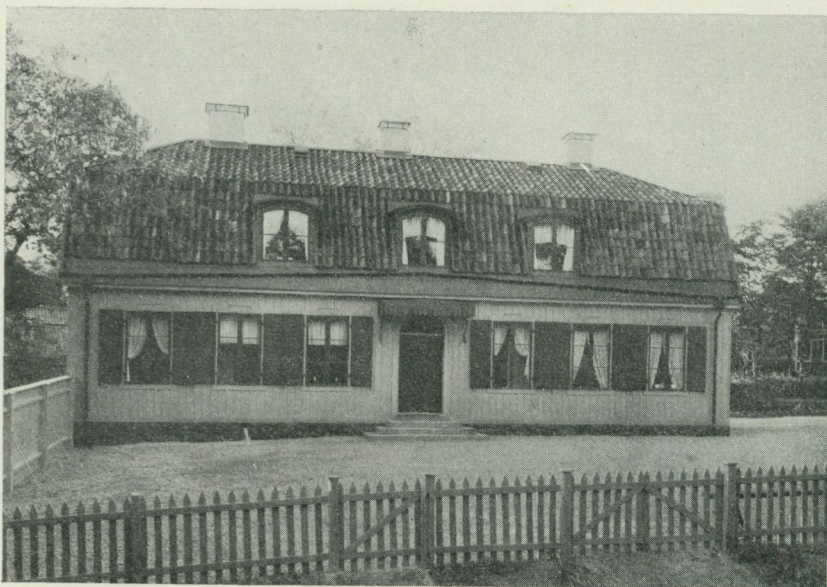
Fig. 2. Hazeliushuset på Skansen. Gårdssidan.
