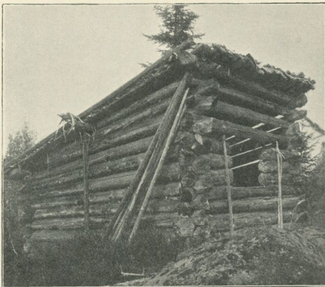
Fig. 8. Löflada, Södra Ängens skog, Gräsmarks sn.
