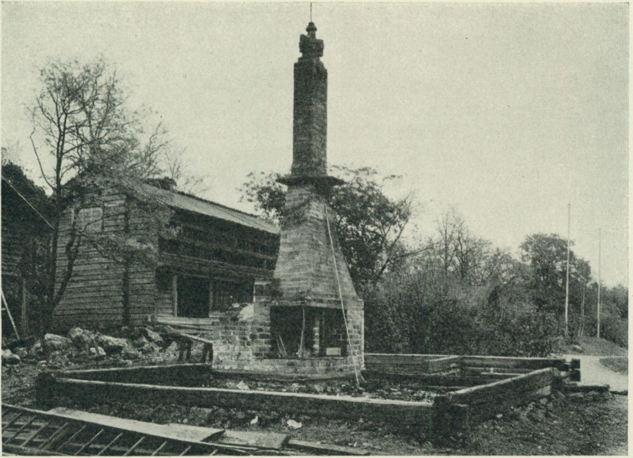
Bild 10. Morastugan. Under rivningen på Skansen för återuppförandet i den nuvarande Dalagården.
