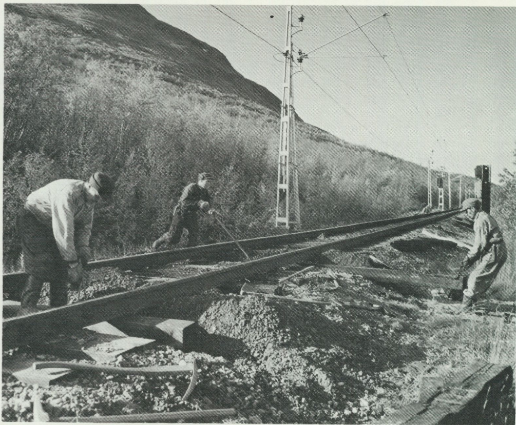
Slipersbyte på Malmbanan i Lappland vid mitten av 1950-talet. Foto SJ bildarkiv.
