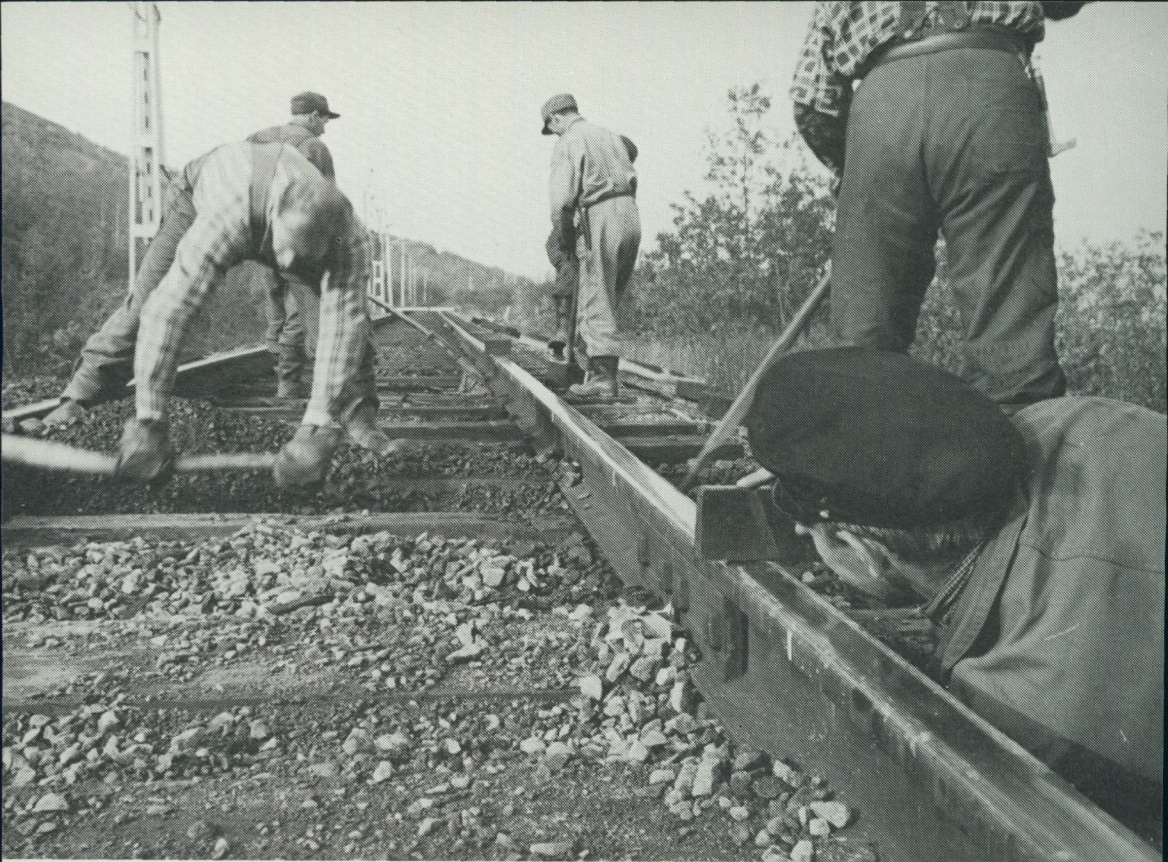
Justeringslyft på Malmbanan i Lappland vid mitten av 1950-talet. Banvakten avgör med ögonmått hur mycket banarbetarna med hjälp av domkraft ska lyfta spåret så att det blir jämnt. Foto SJ bildarkiv.
