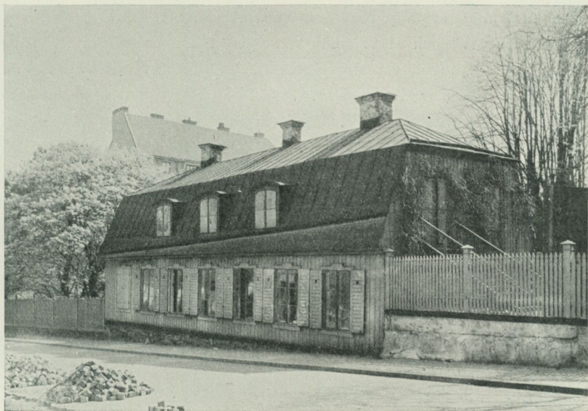
Fig. 7. Hazeliushuset vid Surbrunnsgatan. Omedelbart före flyttningen.
