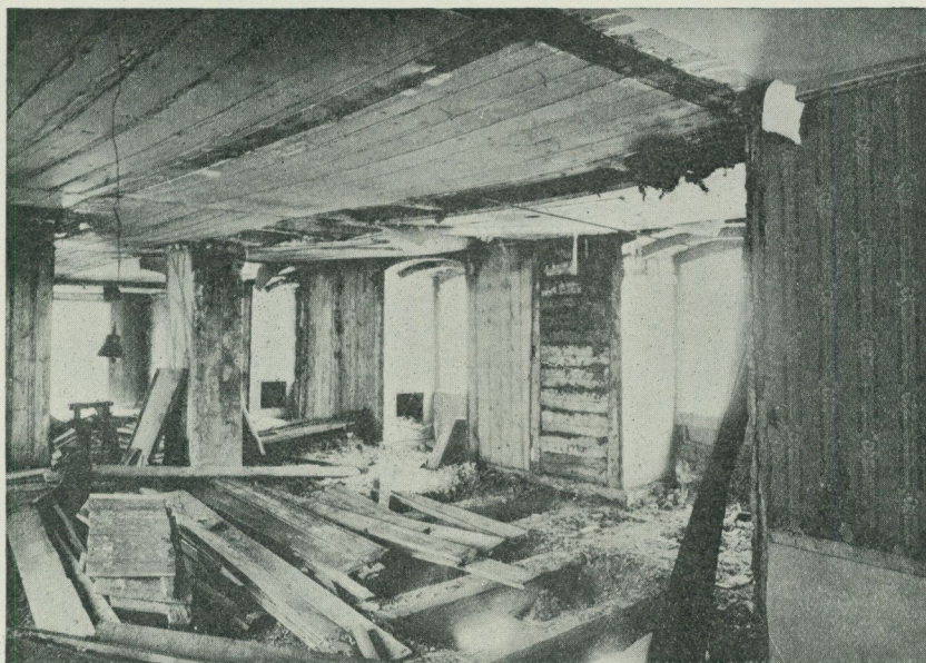
Fig. 26. Vindsvåningen under rivningen. Rummen S, T, U med borttagna mellanväggar men sammanhängande takpanel.
