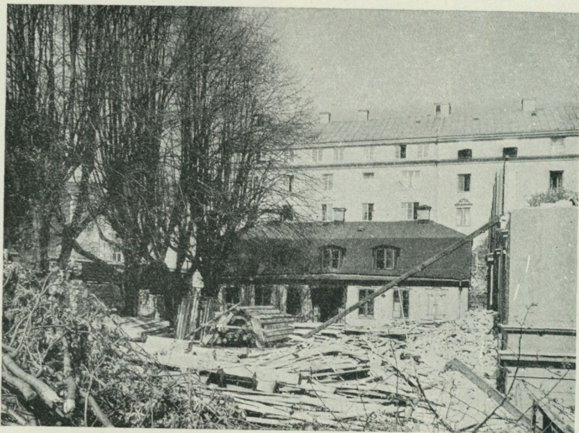
Fig. 4. Tomten vid Surbrunnsgatan under pågående rivning. Till vänster om Hazeliushuset de fyra stora lindarna utmed övre terrassmuren.
