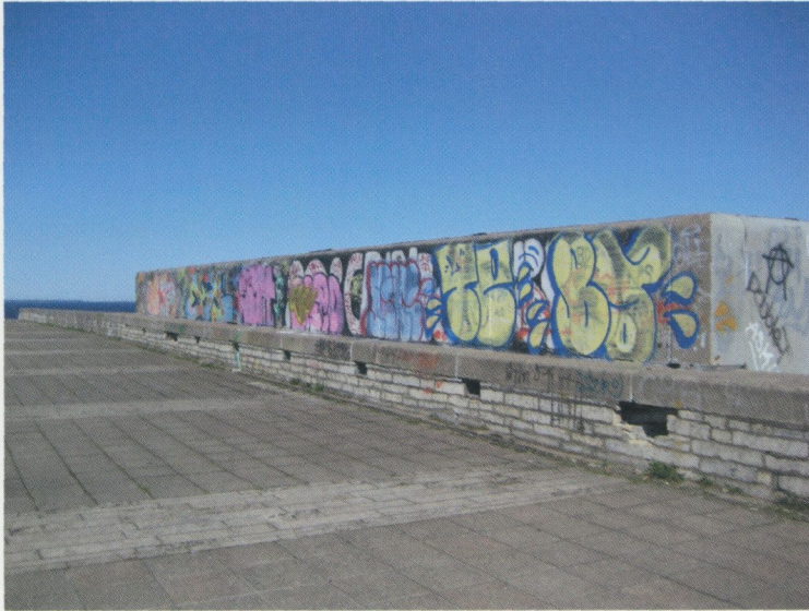
Graffiti målare har satt sin prägel på byggnadens ytor. Foto Beate Feldmann Eellend.
