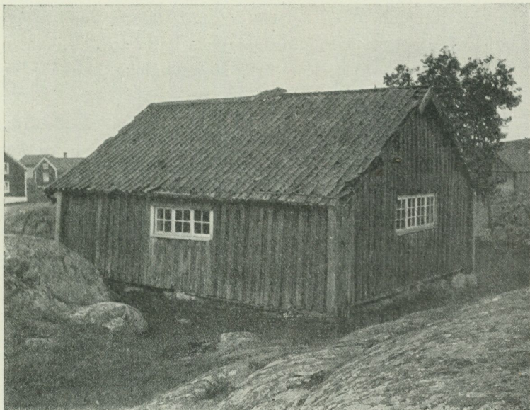
Fig. 2. Korrumhuset från söder.
