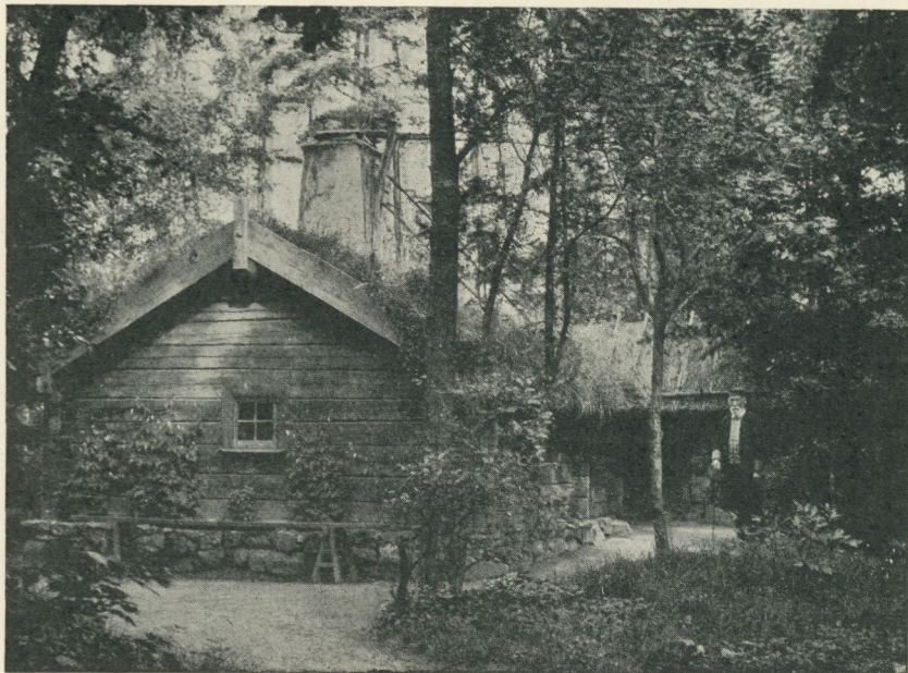
Fig. 12. Hornborgastugan från Västergötland, uppförd 1898.
