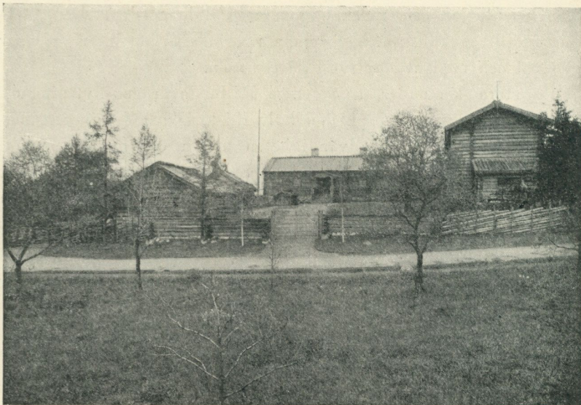
Fig. 16. Älfrosgården från Härjedalen, uppförd 1915—16, sedd från söder; i midten manbyggnaden, till v. ladugård m. m., till h. svalgångsboden.
