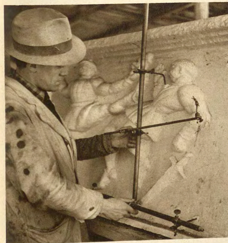
Noggranna mått tagas efter gipsmodellen med punkteringsinstrumentet.
