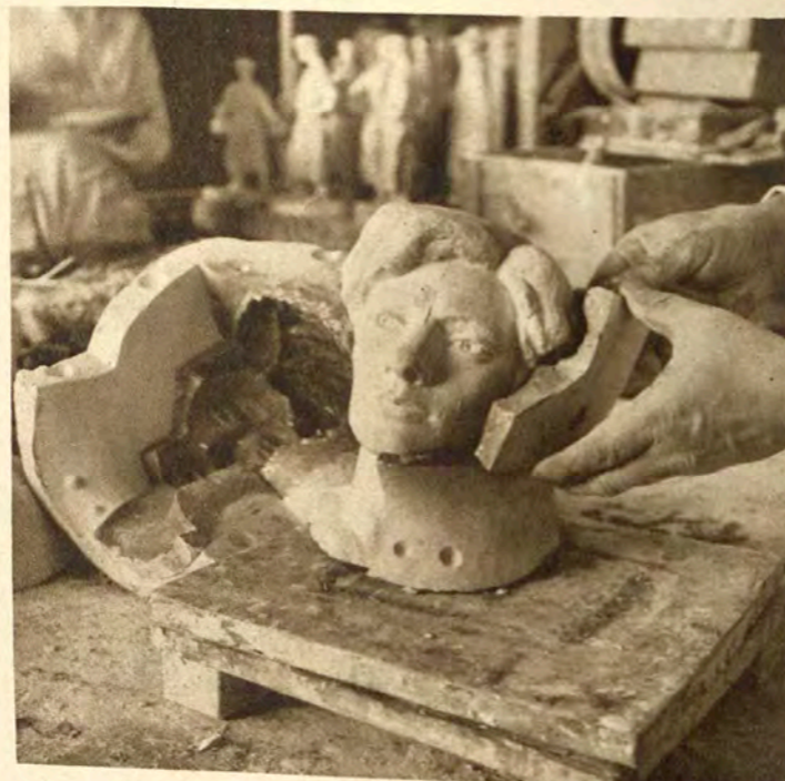
Ett huvud av Grate gjutes här med styckeform. Formstyckena passa väl ihop och ligga samlade inom en omslutande gipsmantel (t. v. på bilden). Fogarna mellan formstyckena retuscheras oftast bort från den gjutna gipsen.
